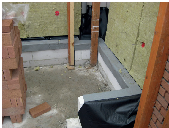
Polylood PP-slabbe bij balkon aansluiting
