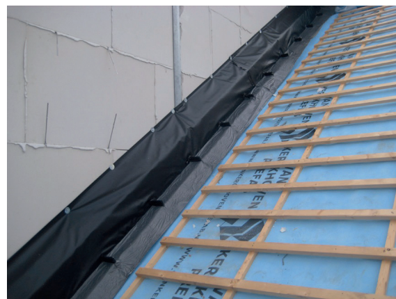
Polylood PP-slabbe als voetlood in schuine geveldrager
