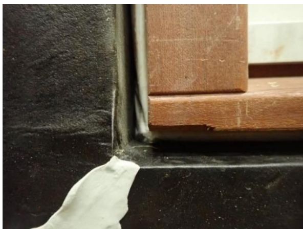
Foto's testelement met Profi Airtight 2.0
