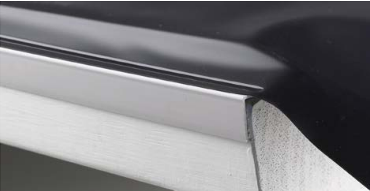
Lateislabbe met hoekprofiel hard op dagmaat kozijn met 'oor'.
